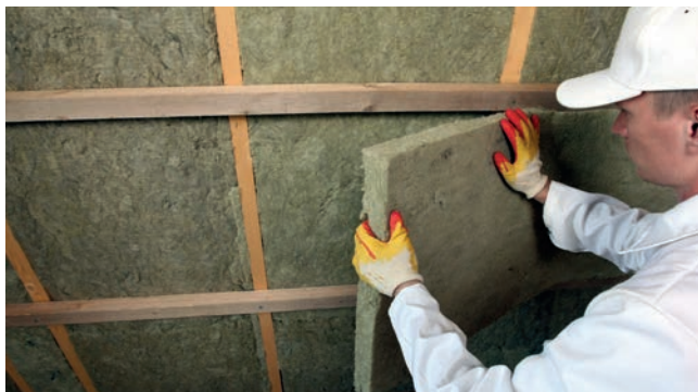
Рис. 4. Укладка второго слоя теплоизоляции
